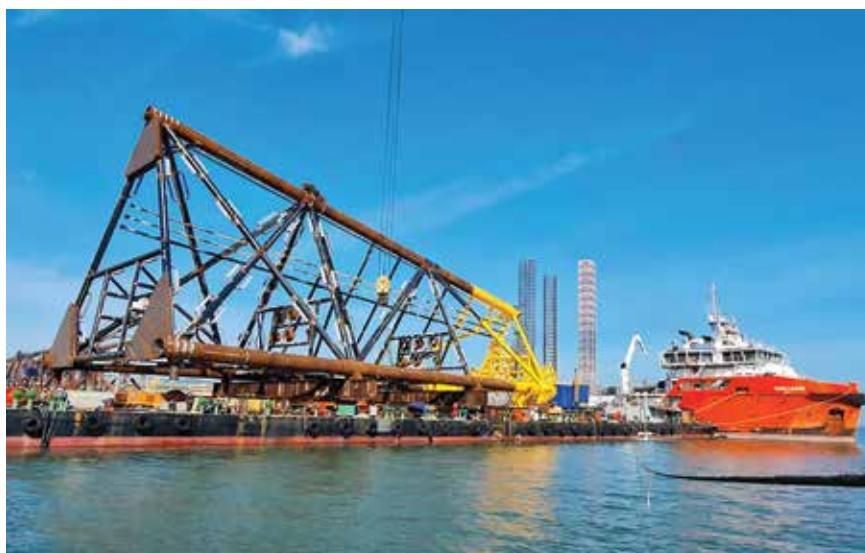
Hạ thủy thành công chân đế giàn RC-10. Ảnh: VSP
