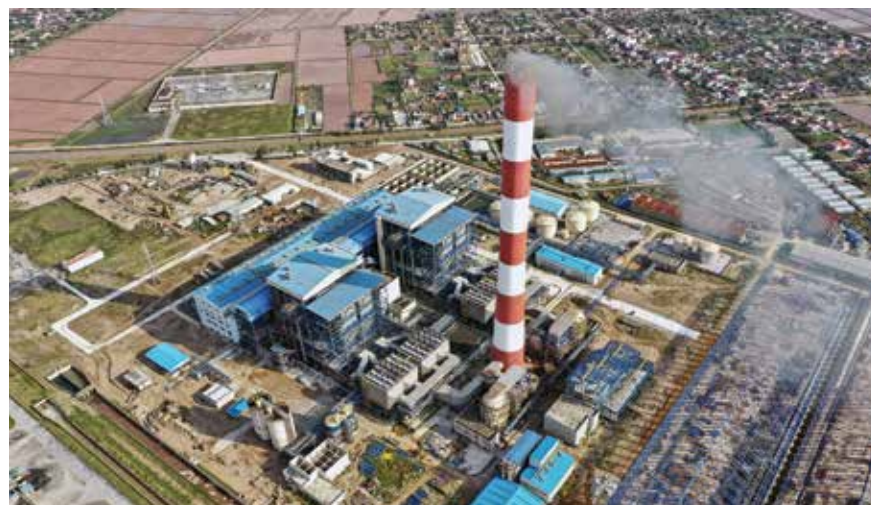
Nhà máy Nhiệt điện Thái Bình 2. Ảnh: PVN
